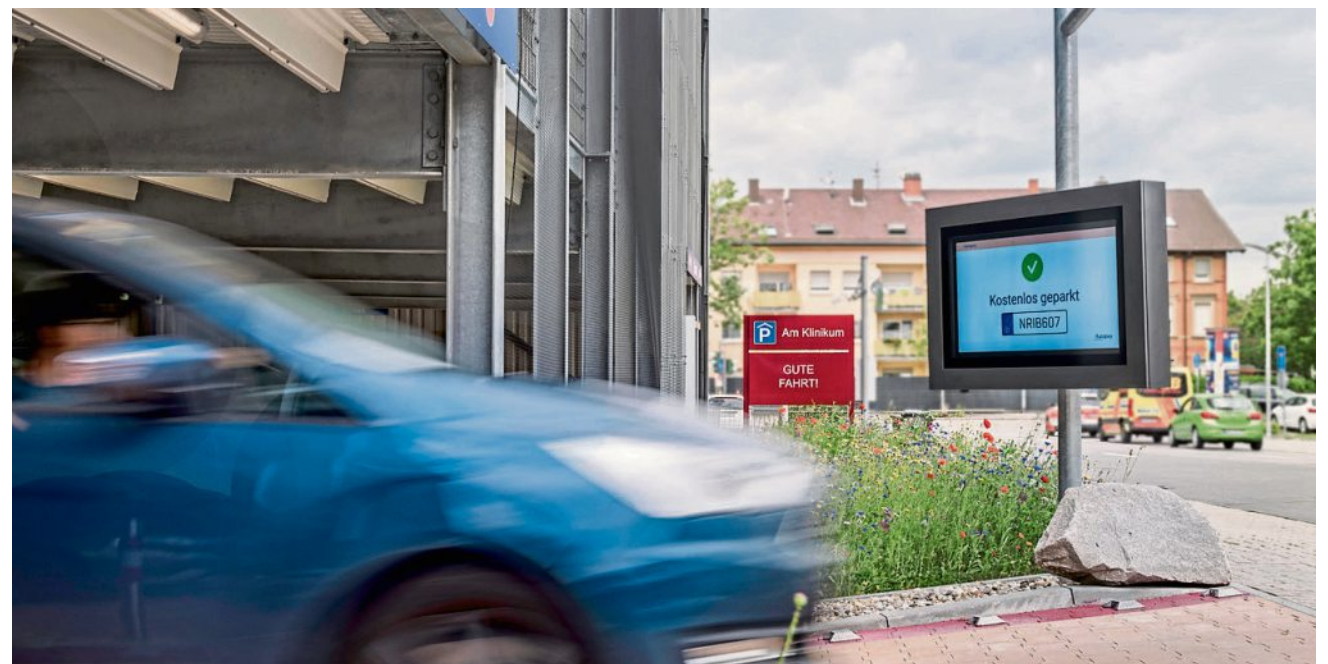
Schranken- und ticketloses Parken durch Erfassung des Kennzeichens bei der Ein- und Ausfahrt mithilfe von Kameras. Foto: AmbiPark
