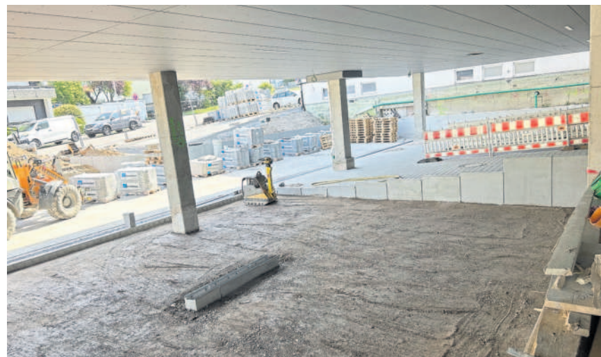
Auch die Arbeiten an den Außenanlagen laufen richtig auf Hochtouren.
