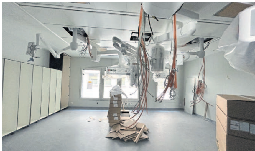
Die zentrale Operationsabteilung ist das Herzstück des Neubaus.
